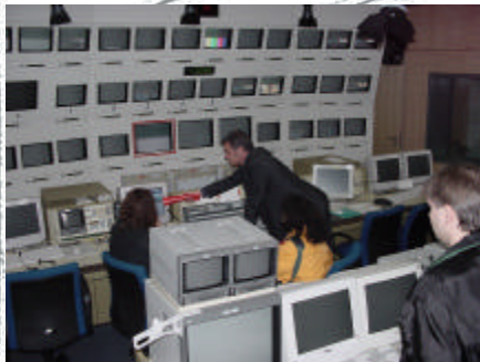
Studioregie im Zollernhof, die softwaregestützt leicht umkonfigurierbar ist. Die Erfahrungen des Betriebspersonals damit sind generell als sehr positiv zu bewerten
